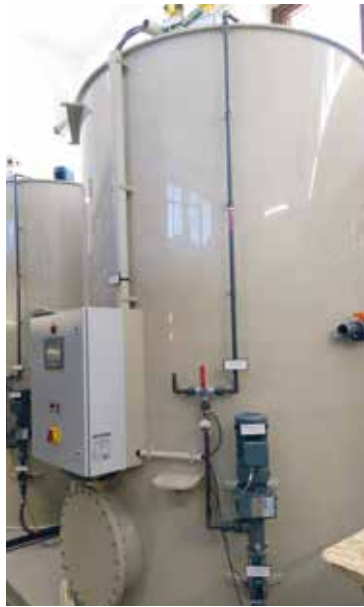
Der entwässerte Klärschlamm, die Dekanter und die Behälter für das polymere Flockungsmittel
