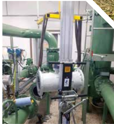
Großes Bild: Übernahmestation Butterlake Linkes Bild: neuer Zähler an der Montagehilfe Rechtes Bild: der neue Zähler ist eingesetzt
