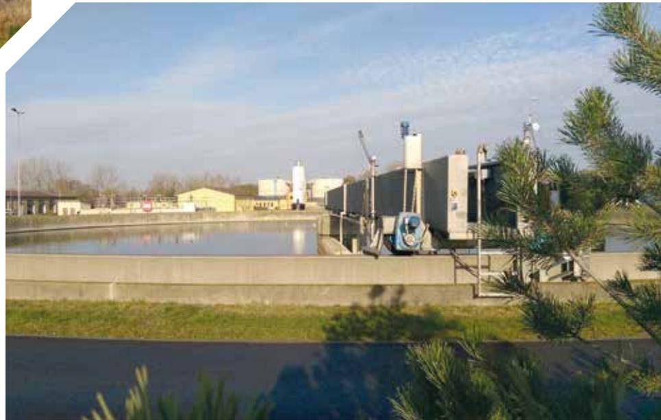
Um den Phosphor im Sandfilter zurückhalten zu können, ist zunächst eine gezielte Umwandlung der Phosphoranteile erforderlich, die im Abwasser in gelöster Form vorkommen. Mittels geeigneter Fällungsmittel auf Basis von Eisen- oder Aluminiumverbindungen werden diese zu ungelösten Phosphatflocken umgewandelt. Unter dem ständigen Einsatz eines Rührwerks wachsen die Flocken zu großen, im Filter abfiltrierbaren Partikeln heran.
