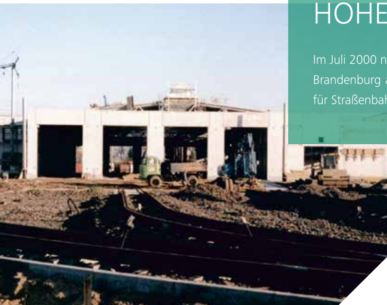
Der Bau des Betriebshofes in der Upstallstraße
