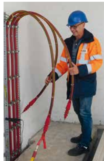
René Laschet beim Vorbereiten einer Kabelprüfung
