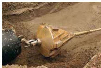
Das mit Einzug der Leitung verdrängte Bentonit musste aufgefangen und entsorgt werden. Anschließend wurde der neue Leitungsabschnitt mehrfach gründlich gespült und desinfiziert.
