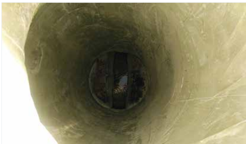
Die neue Schachtauskleidung.
