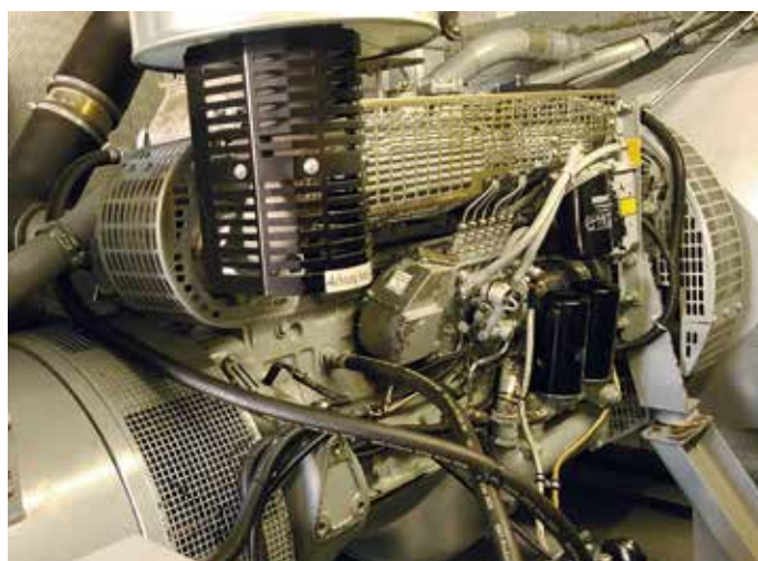
Die dieselbetriebene Netzersatzanlage.
