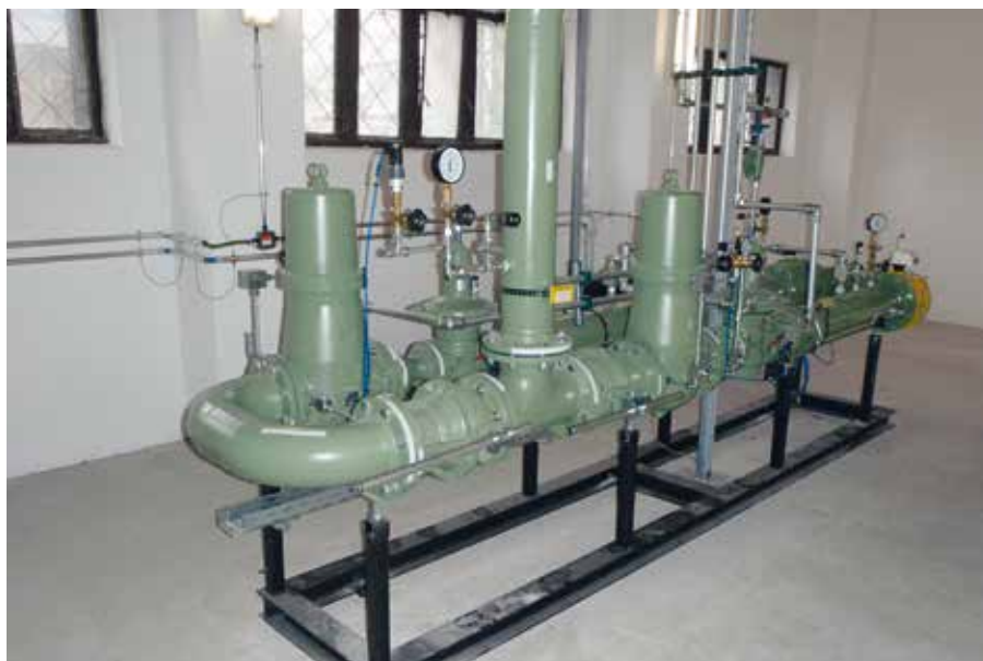
Die 2-schienige Gasdruckregel- und Messanlage in der Ortsstation Caasmannstraße.
