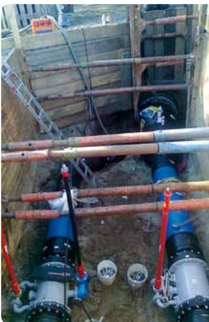
Mit belastungsstarken Verbauungssystemen gestützte Baugrube
