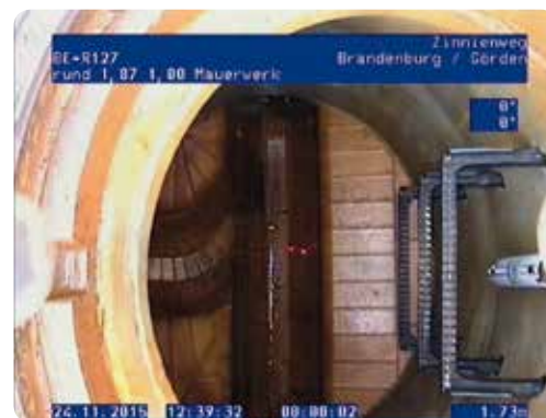
Geöffneter Regenwasserschacht nach der Reinigung.
