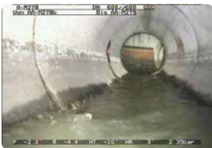
Der Abwasserkanal in Betrieb.
