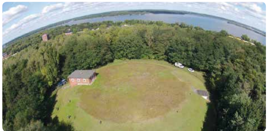
Blick auf den Weinberg mit Hochbehälter in Kirchmöser. Er ist nicht hoch genug um den Wasserdruck in den übrigen Stadtgebieten zu gewährleisten.
