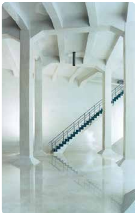
Hochbehälter in Kirchmöser
