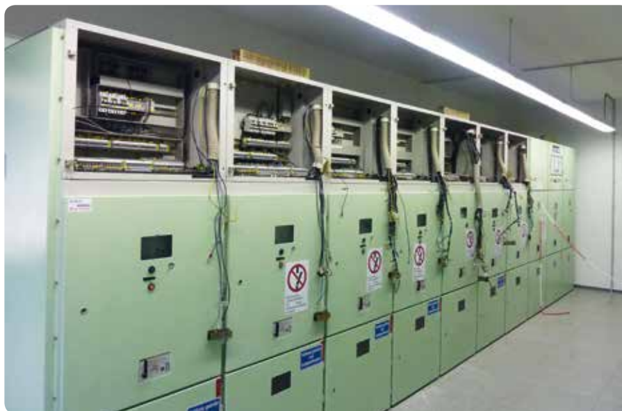
Das Bild zeigt die Modernisierung der 10,5 kV Mittelspannungsschaltanlage im Heizkraftwerk.
